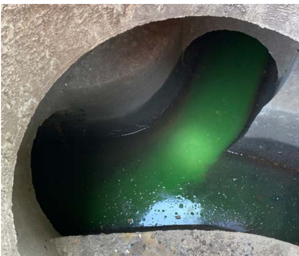
Abbildung 5: Farbwasserprobe im Kanal (Quelle: Hamburger Stadtentwässerung AÖR)
